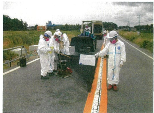
写真-7 国道6号での緊急路面補修状況
