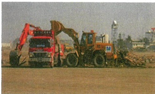
写真-6 B滑走路の瓦礫撤去状況
