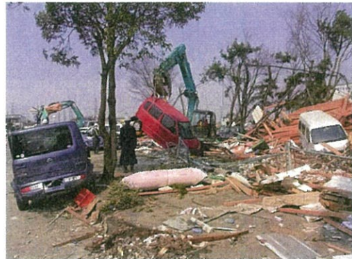
写真-4 夢メッセ 仙台港区支障物撤去工事
