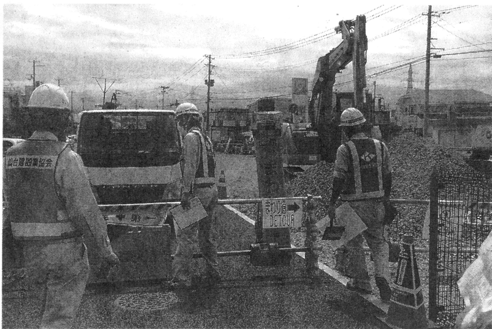
黄色やピンク色で色分けした標識・バリケードで災害防止を徹底していた日建工業の現場
