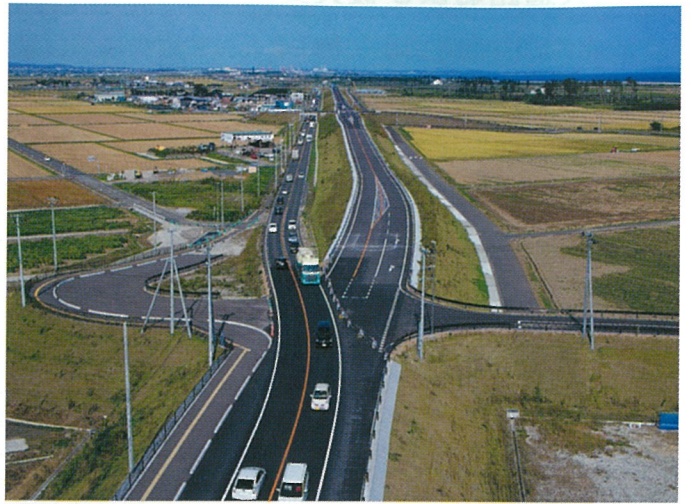
▲ 仙台市東部復興道路整備事業（主）塩釜亘理線（かさあげ道路）舗装新設工事（5工区）（宮城県仙台市）： 日建工業(株)
