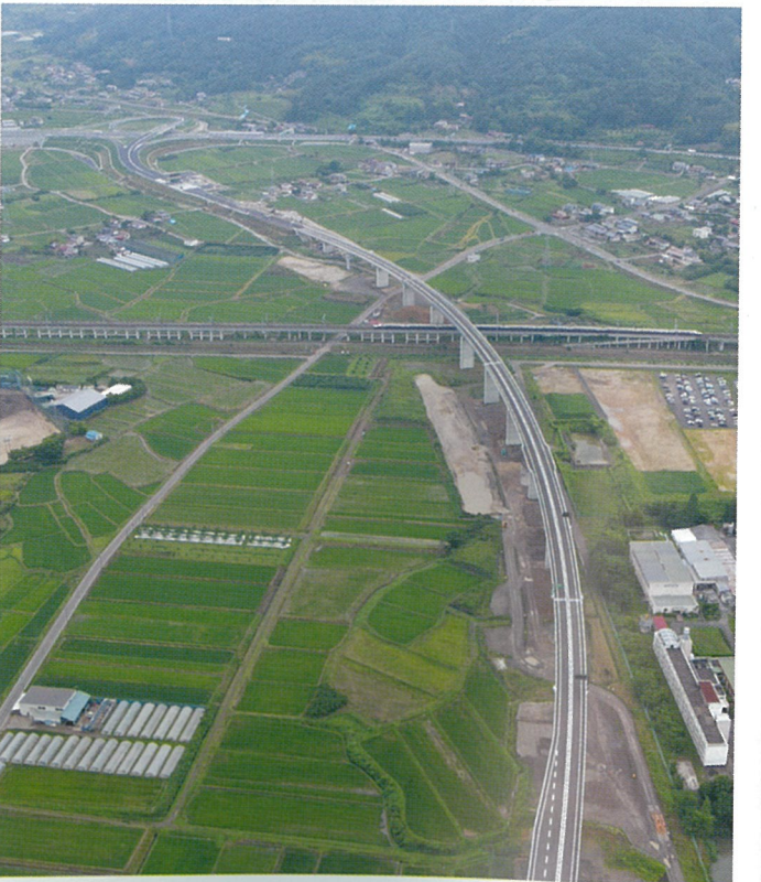
▲ 桑折高架橋外舗装工事（福島県桑折町）： 日建工業(株)
