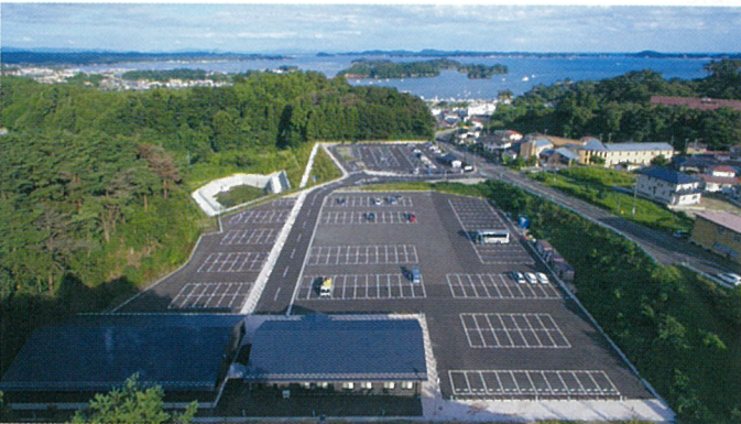
▲ 三十刈地区避難場所整備その3工事（宮城県松島町）： 日建工業(株)
