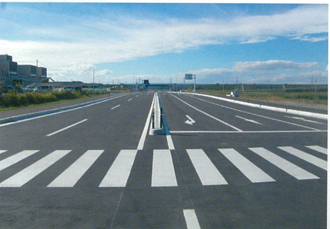
▲ 石巻地区舗装工事（宮城県石巻市）： 日建工業(株)
