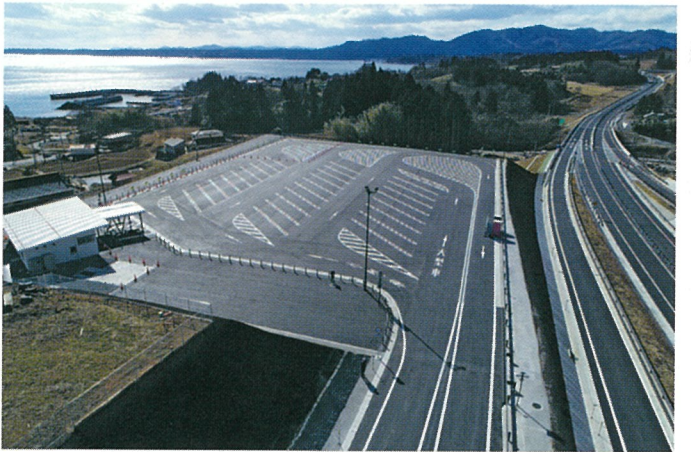
▲ 赤牛地区舗装工事（宮城県気仙沼市）： 日建工業(株)
